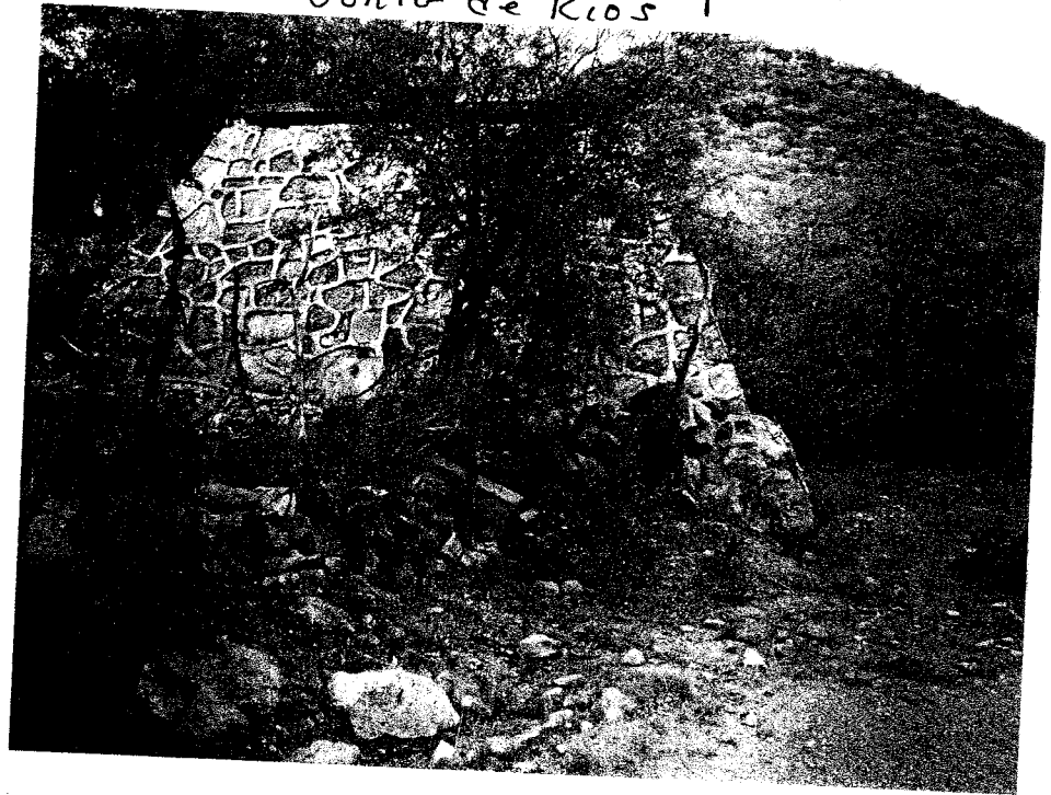
Depósito Agua potable Junto de Ríos.
