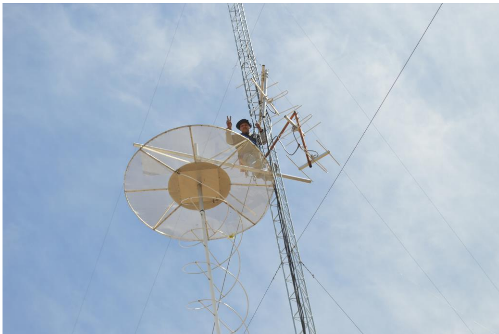
Mantenimiento de la torre de telecomunicaciones
